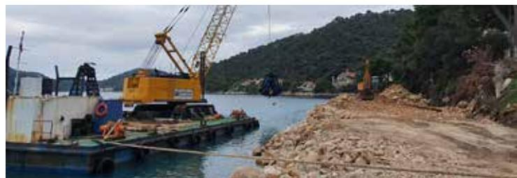
Projekt rekonstrukcije i proširenja luke Ubli na Lastovu napreduje sukladno planiranoj dinamici. Na gradilištu su u tijeku radovi na iskopu u čvrstoj i kompaktnoj stijeni, finom planiranju temeljnog kamenometa ispod obalne konstrukcije i izradi betonskih elemenata u izdvojenom pogonu i ugradnji istih na gradilištu.
